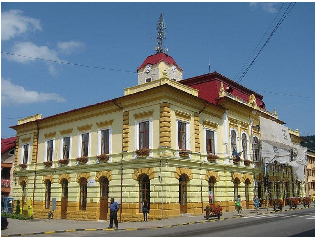
Clădirea monument istoric a primăriei orașului
